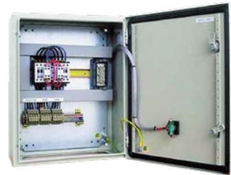
Umschalterschütze / Load transfer switch panel
